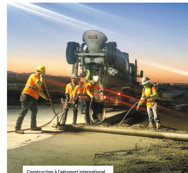
Construction à l'aéroport international de Los Angeles d'une voie de circulation (taxiway) de 1,1 kilomètre
