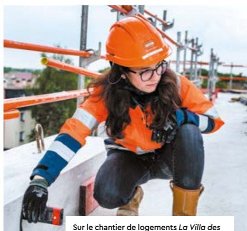
Sur le chantier de logements La Villa des Glycines au Plessis-Tréville (Val-de-Marne)
