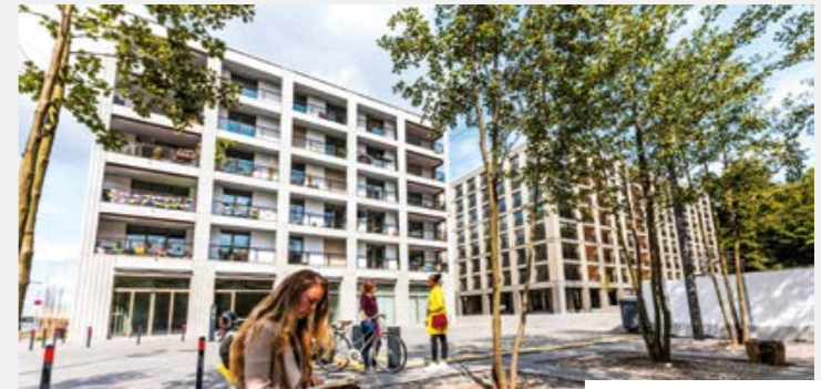
Présenté à l'état de projet dans le cadre de la COP 21 à Paris, l'écoquartier Green City propose aujourd'hui des bâtiments sobres en énergie et des solutions de mobilité douce.
