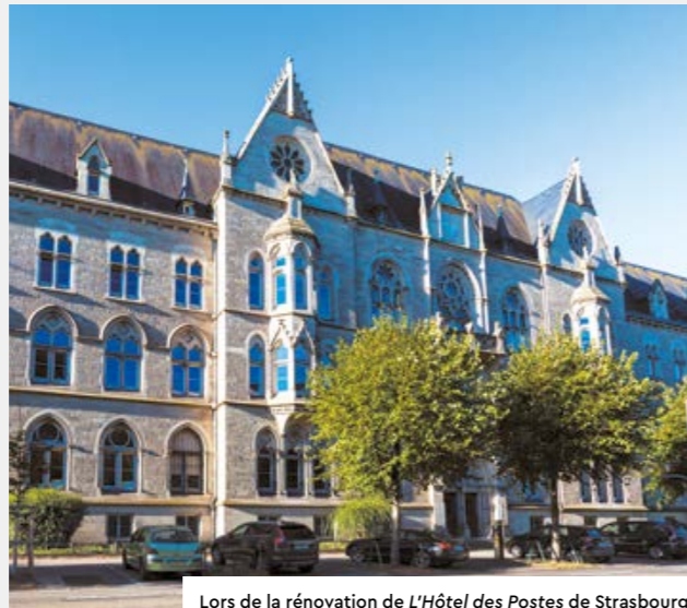
Lors de la rénovation de L'Hôtel des Postes de Strasbourg, 20 000 m 2 de structures existantes ont été conservées, 1 000 châssis en bois valorisés et 2 700 m 2 de moquette recyclés.
