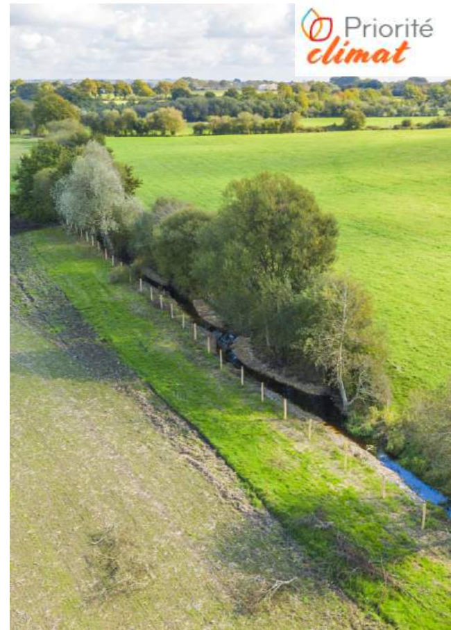
Travaux de restauration des cours d'eau du bassin versant de Brière-Brivet à Crossac - France
