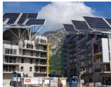
Démonstrateur ABC Bâtiment autonome (Grenoble)
