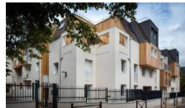
Rénovation énergétique - Arpajon
