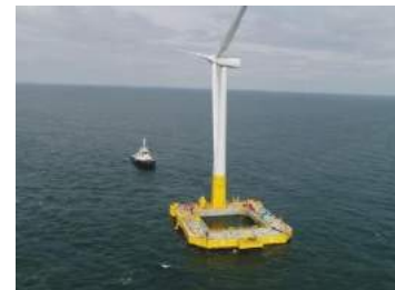
Eolienne offshore – Floatgen
