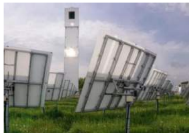
Centrale à concentration solaire Projet pilote – Kraftanlangen (Jülich)
