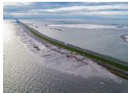
Travaux fluviaux et maritimes
