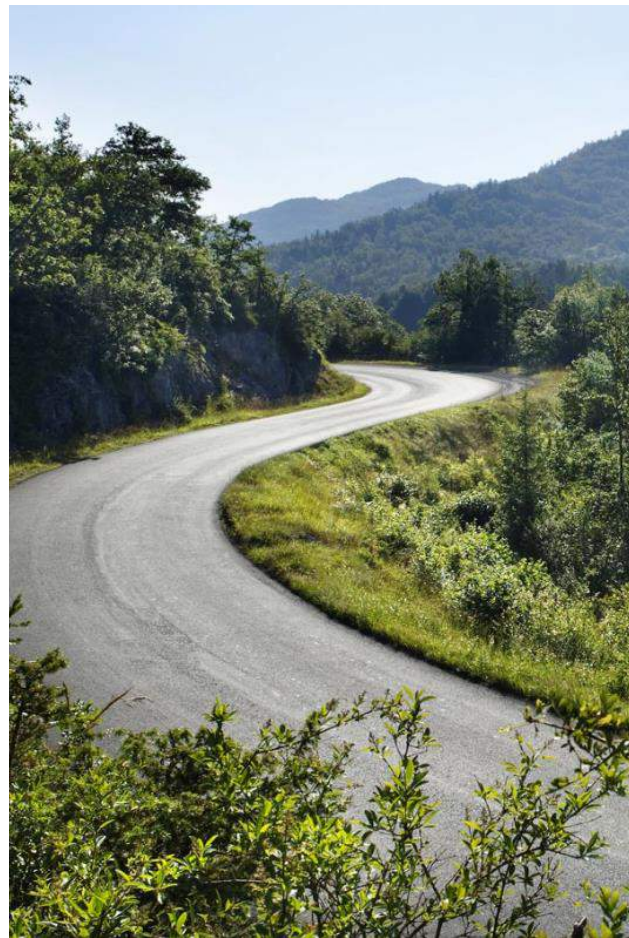
Mise en œuvre de Valorcol (enrobé à froid écologique 100% recyclé) sur la RD 19 dans l'Aude - France
