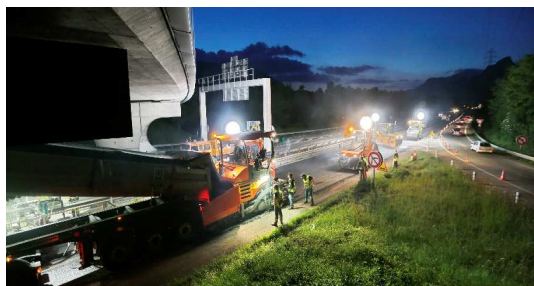
Réfection de chaussées sur la rocade de Grenoble
