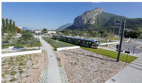
Réalisation des infrastructures de la ligne B du tramway de Grenoble
