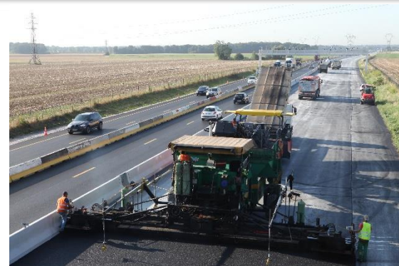
Réfection des chaussées de l'autoroute A6 – Essonne
