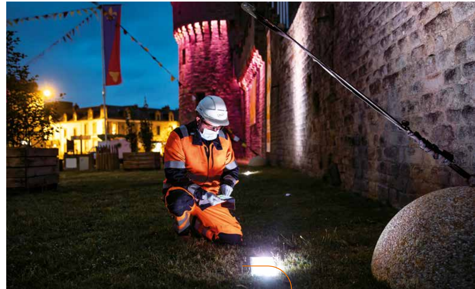
Wartungsarbeiten an der Straßenbeleuchtung der mittelalterlichen Stadt Guérande in der Region Loire-Atlantique in der Region Loire-Atlantique in Frankreich.
