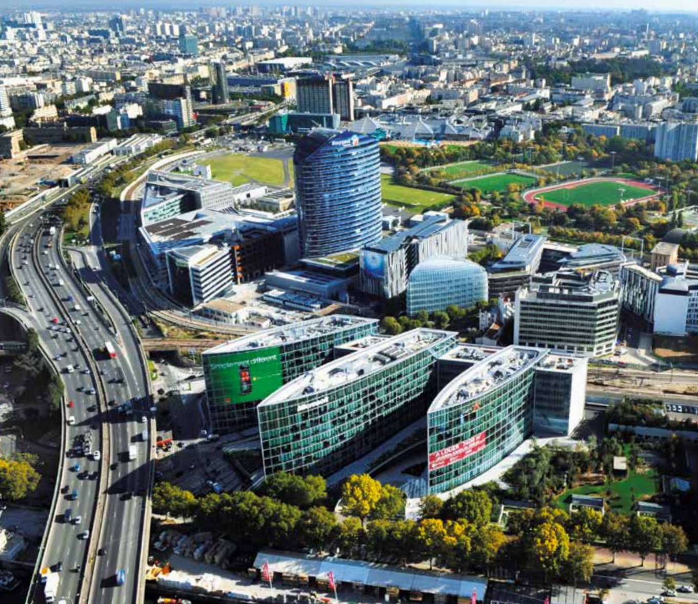
IssyGrid®, das unter der Federführung von Bouygues Immobilier in Issy-les-Moulineaux in der Nähe von Paris entstand, ist das erste operative Smart Grid im Maßstab eines Stadtviertels in Frankreich.
