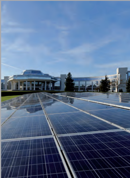
„Challenger“, Hauptsitz von Bouygues Construction, der zurzeit ökologisch saniert wird
