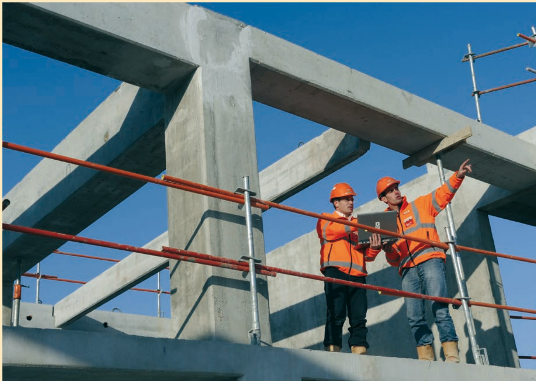
Nicolas Seailles et Jérôme Hollinger de Bouygues Bâtiment Ile-de-France sur le chantier du centre commercial d'Aubervilliers.
