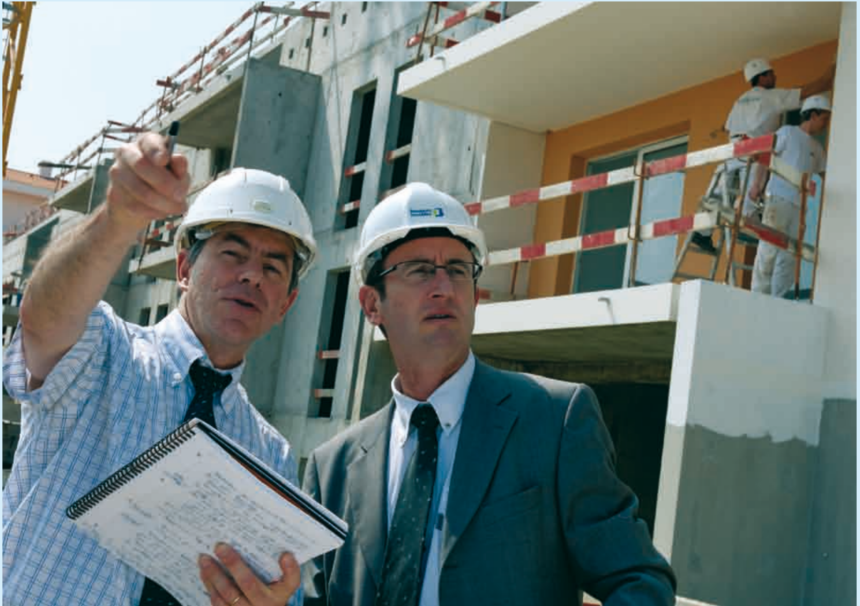
À droite, Philippe Chauvin, responsable technique chez Bouygues Immobilier à Nantes, en visite de chantier à la Roche-sur-Yon avec un architecte du cabinet Cetrac.
