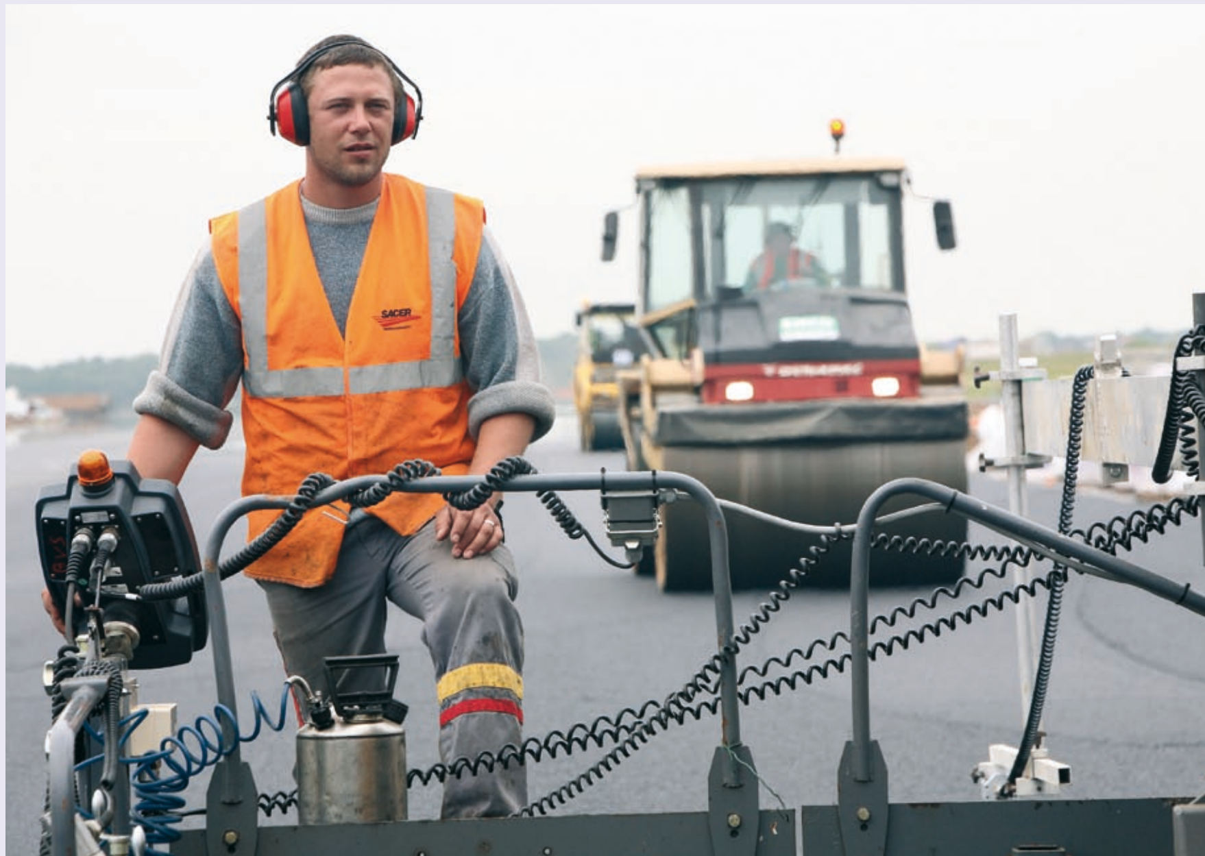
Jérémie Guérin, régleur finisseur chez Sacer PNE (Colas), sur le chantier de réfection de la piste de l'aéroport de Beauvais
